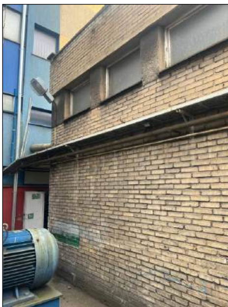
Brudna i przebarwiona elewacja wschodnia
