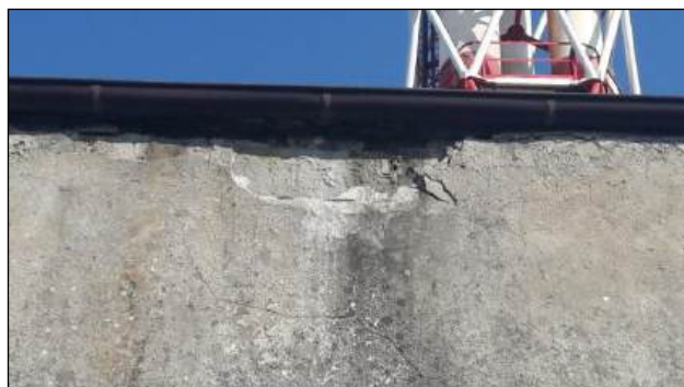
Uszkodzenia tynku w elewacji - pas podrynnowy
