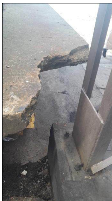
Uszkodzenie rampy w elewacji północnej.
