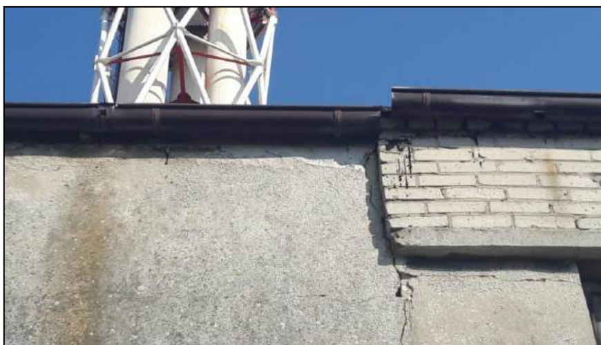
Przerwane orynnowania na połączeniu starej części budynku z nową - elewacja zachodnia.
