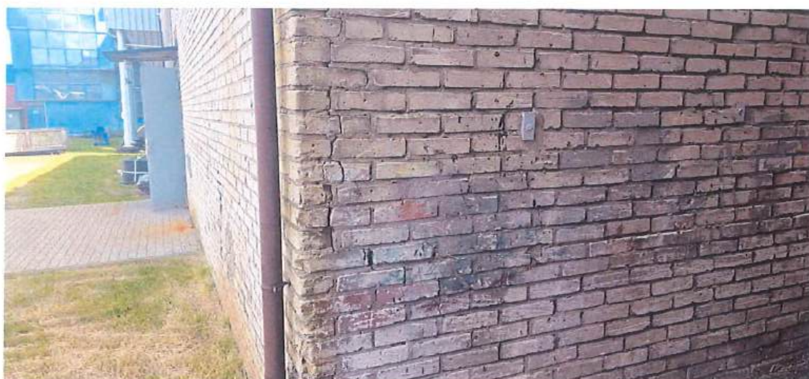
Fot.3 Pęknięcie przemurowania w narożniku
