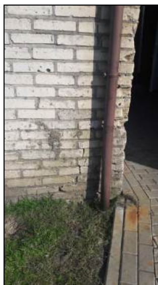
Uszkodzenia muru nieotynkowanego.
