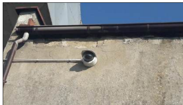
Uszkodzenia tynku w elewacji - pas podrynnowy
