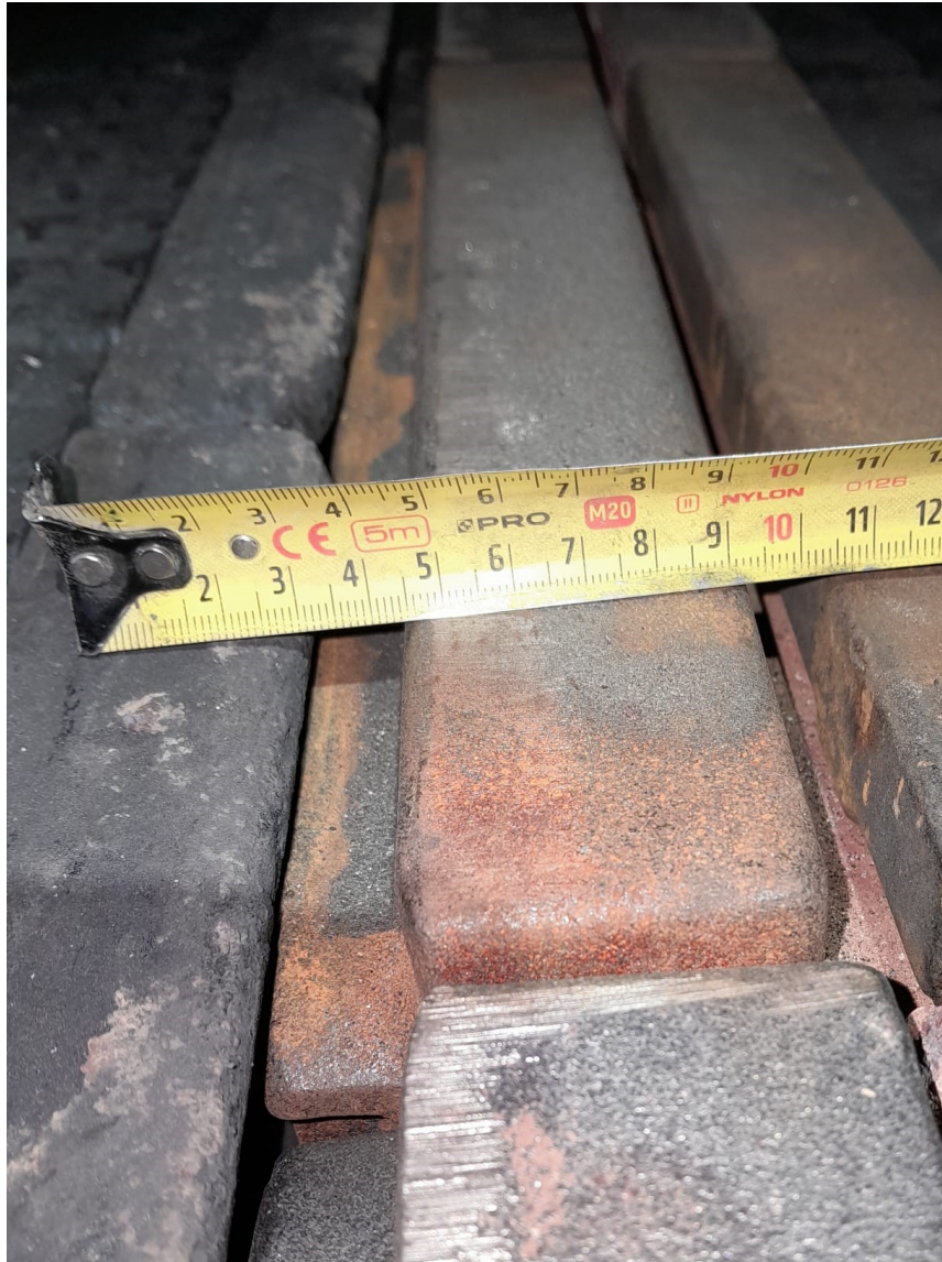
Zdjęcie 3.10 Uszczelnienie boczne – pokład prawy, strona lewa
