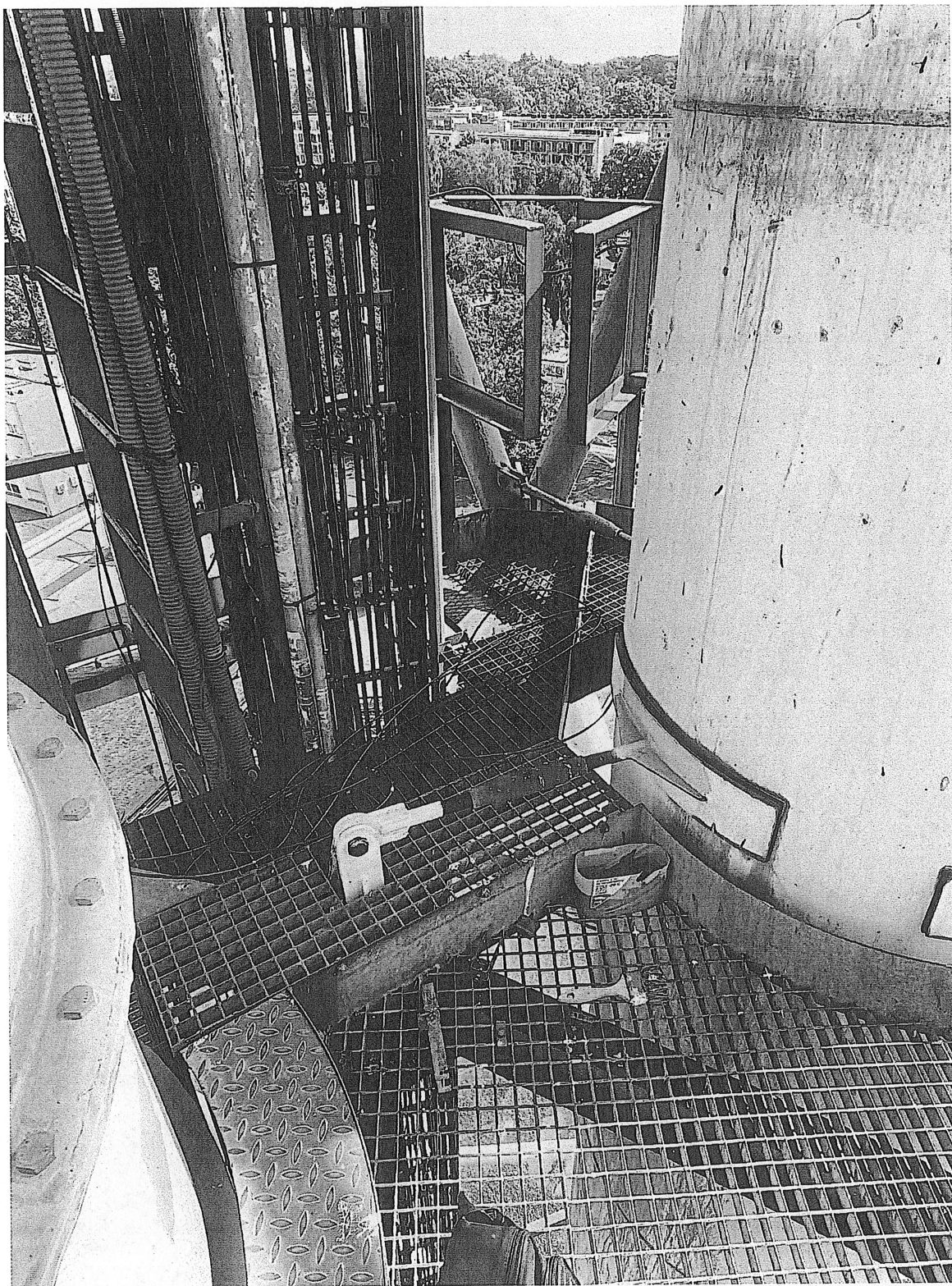
Fot. nr 4 – Przewody wokół dojścia do drabiny – konieczne uporządkowanie
