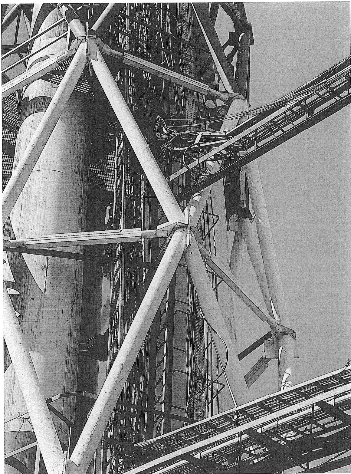
Fot. nr 4 – Przewody dochodzące do konstrukcji wsporczej – konieczna analiza, lub wprowadzenie od podstawy
