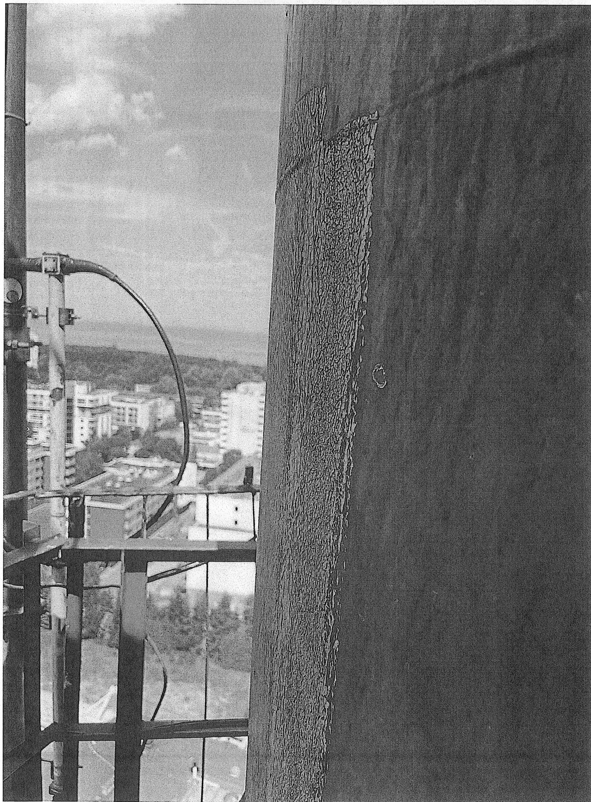
Fot. nr 4 – Braki/ uszkodzenia malowania poz. +56.0m – konieczność powtórnego nałożenia powłok
