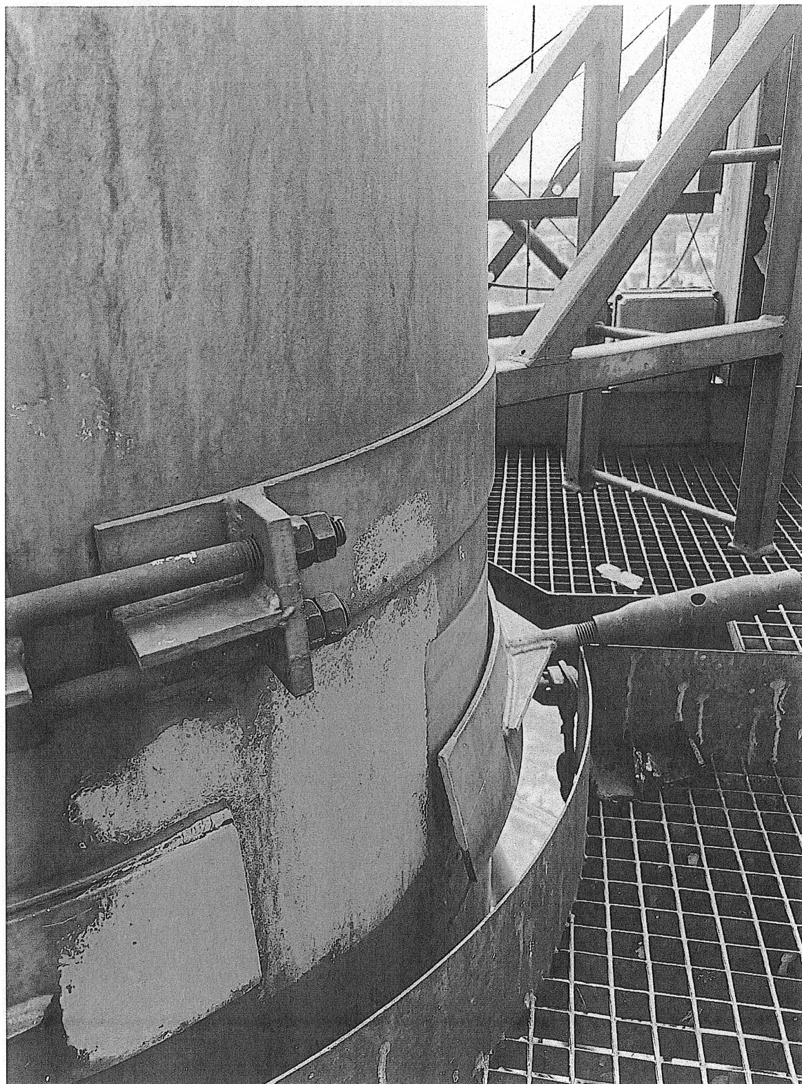
Fot. nr 4 - Uszkodzenie odpory stabilizującej – wymagana naprawa
