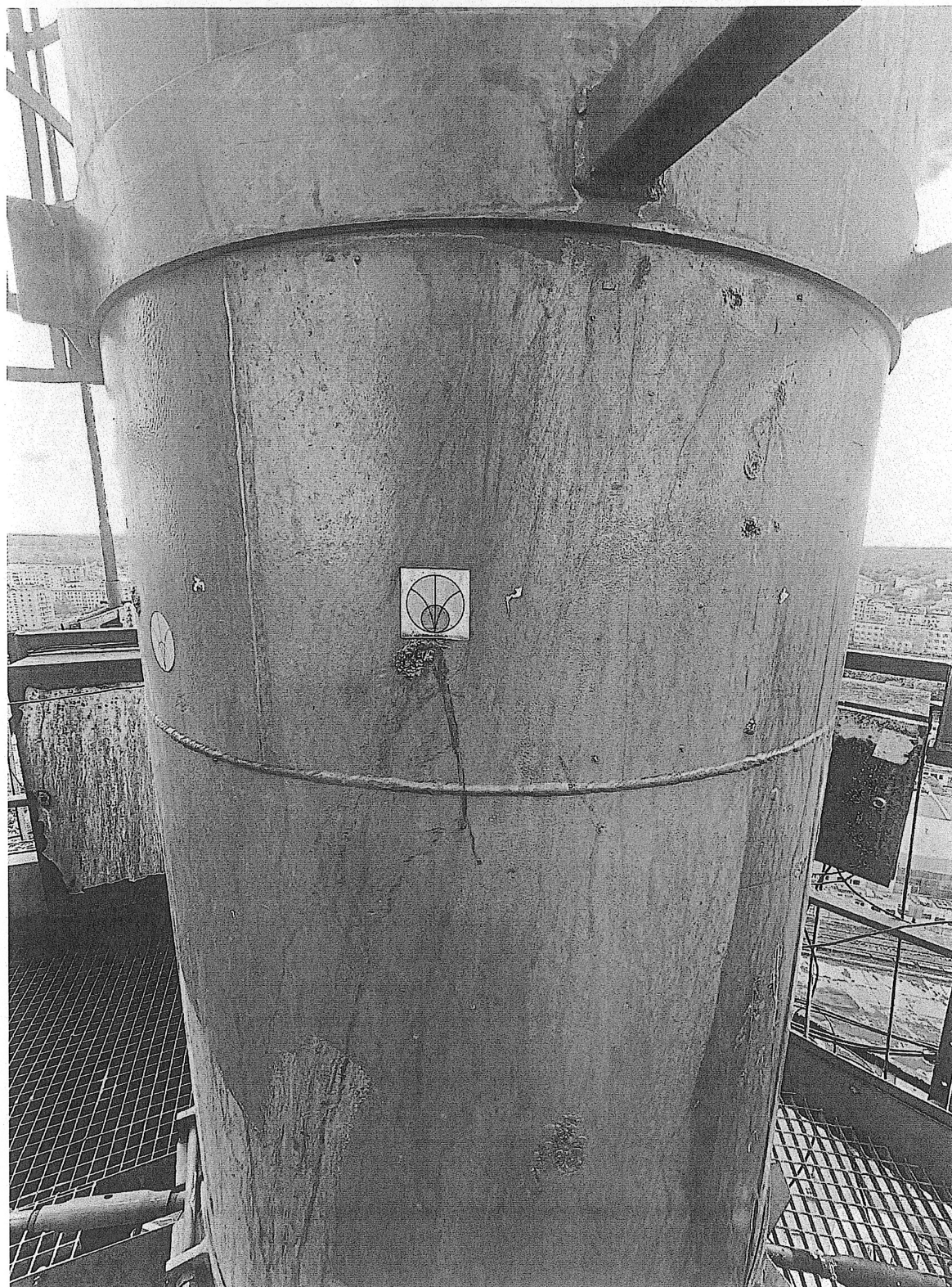
Fot. nr 4 – Korozja na przewodzie nr 2 poz. +56.0m
