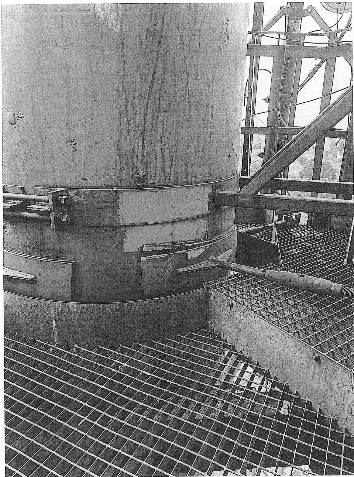
Fot. nr 4 – Uszkodzenie odpory stabilizującej – wymagana naprawa
