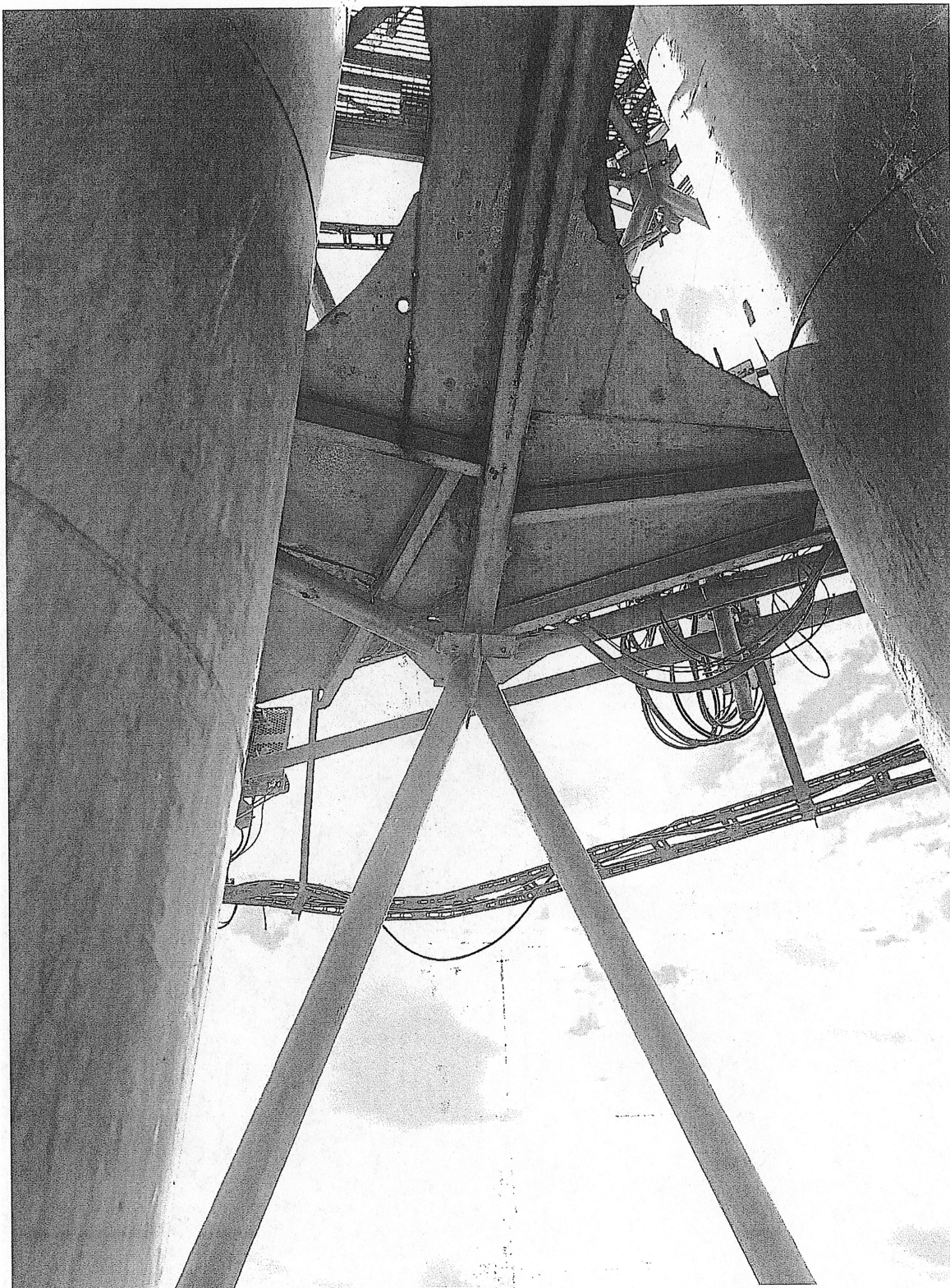
Fot. nr 4 – Widok na przeponę zabudowaną blachą ryflowaną – konieczność oczyszczenia i wykonania malowania antykorozyjnego.
